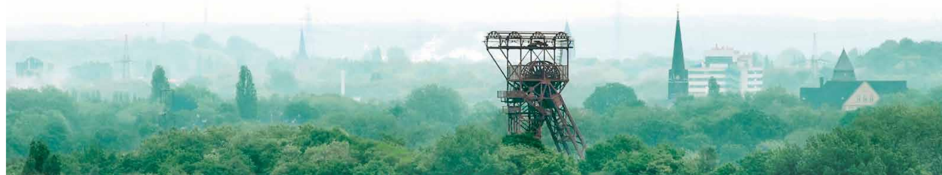
UNESCO-Welterbe Zollverein, Blick auf das Fördergerüst von Schacht 3/7/10 Richtung Gelsenkirchen-Rotthausen
